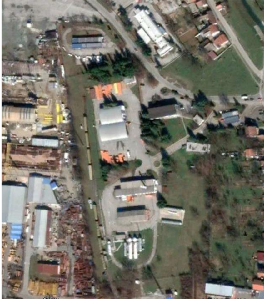
Slika 1: Mikrolokacija područja postrojenja PJ UNP Terminala skladišta Slavonski Brod operatera INA Industrija nafte d.d.
