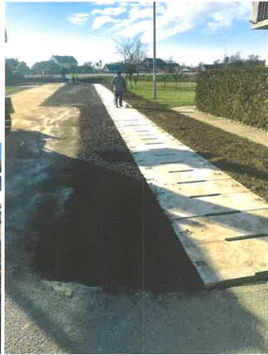
Slika 7a i 7b. Kanal Srednje u Vrpolju nakon uređenja i nakon stavljanja poklopaca
