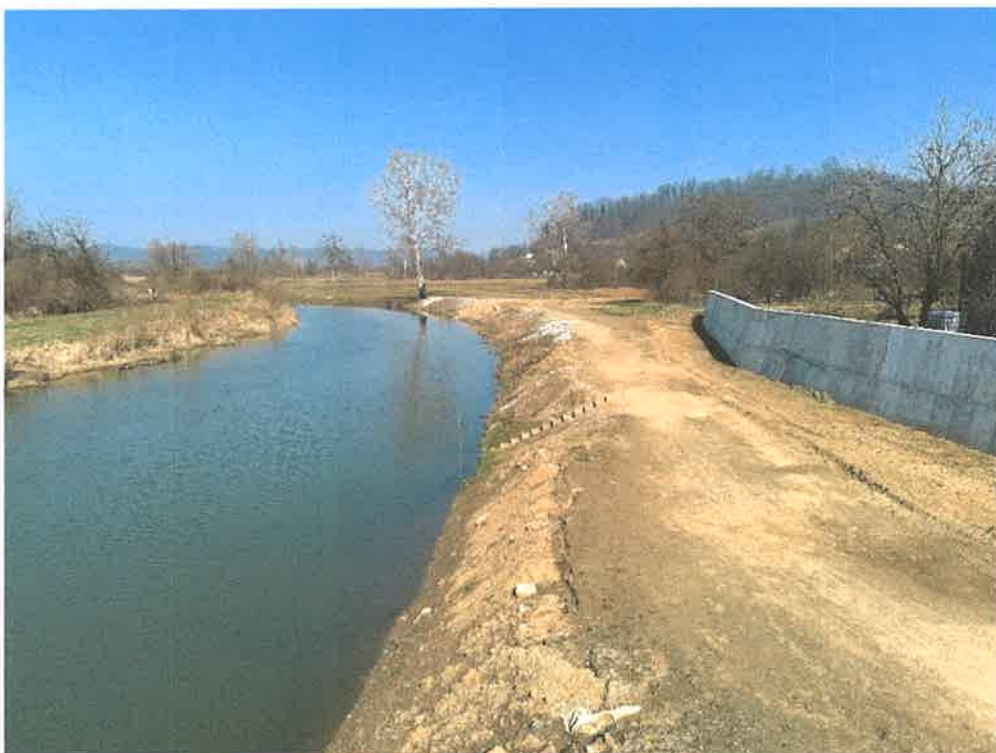
Slika 13. Regulacija rijeke Orljave i izgradnja obrambenog zida u Cigleniku
