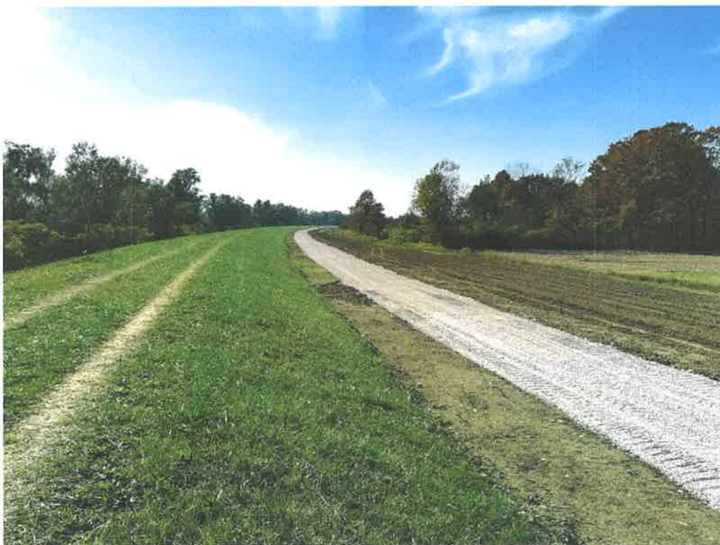
Slika 14. Radovi modernizacije savskog nasipa
