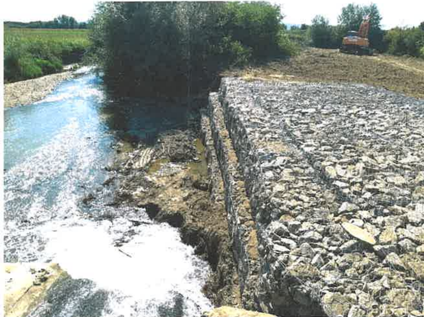
Slika 3. Osiguranje obale gabionskim koševima na rijeci Orjavi, Žakić mlin
