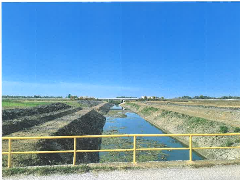
Slika 4. Uređeno korito vodotoka Biđ uz most na cesti Divoševci – Donji Andrijevi
