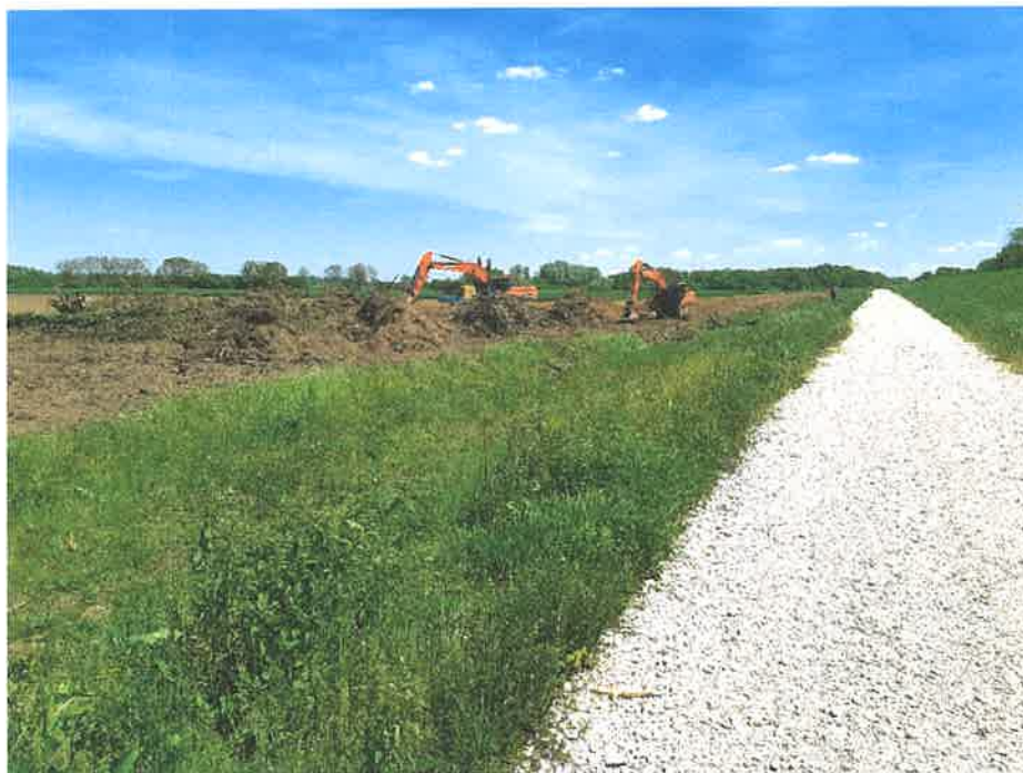
Slika 1. Radovi na uređenju zaobalnog pojasa uz savski nasip, općina Oprisavci
