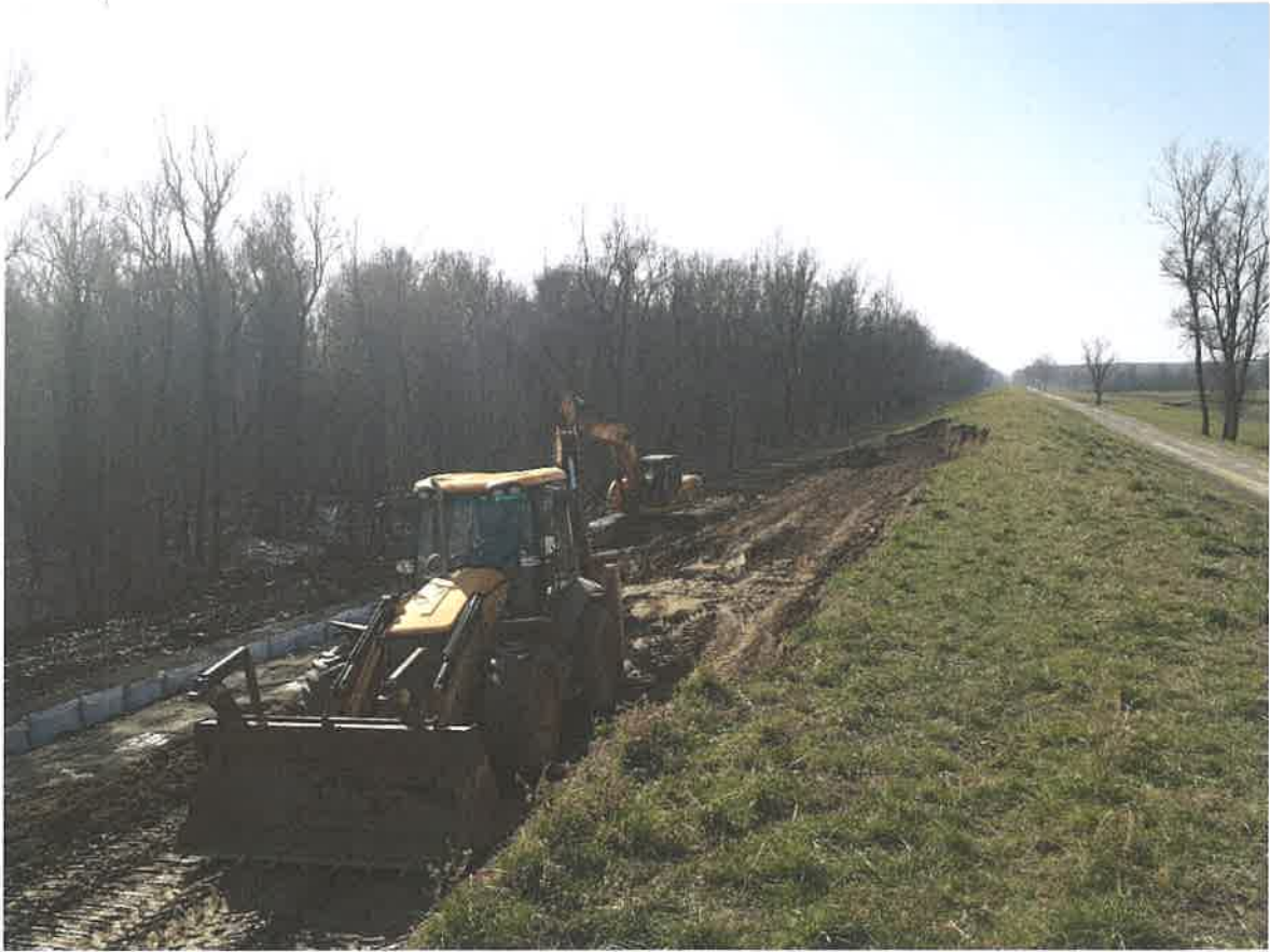
Sanacija klizišta Stara Gradiška
