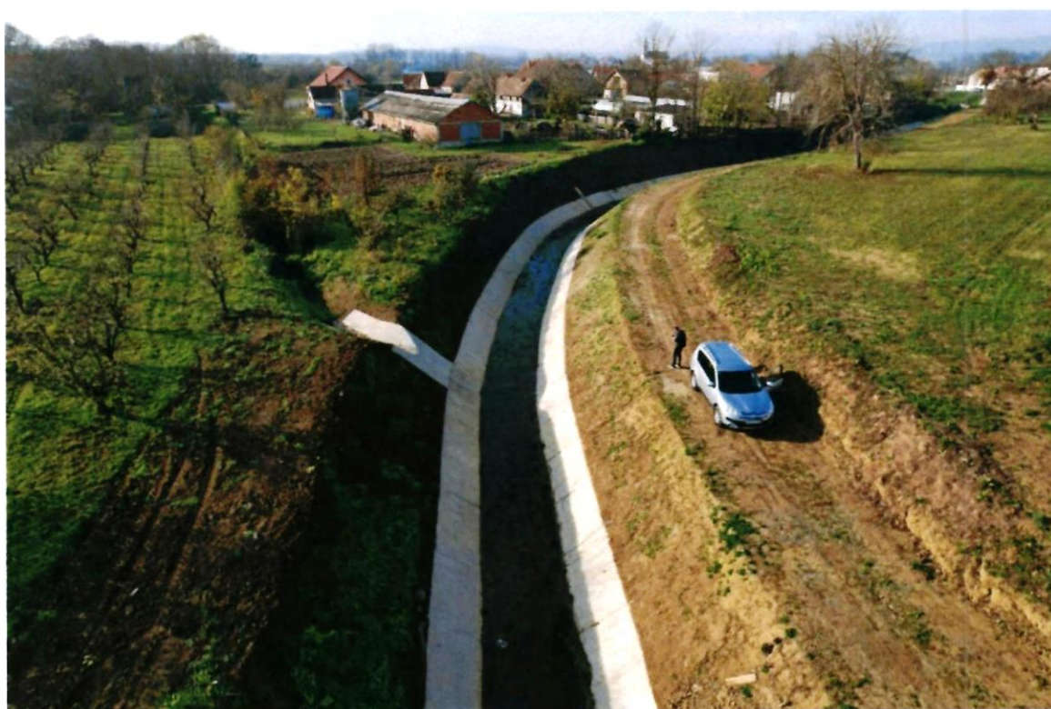
Slika 8. Uređenje korita v. Brezna, naselje Trnjani – nakon izvođenja radova
