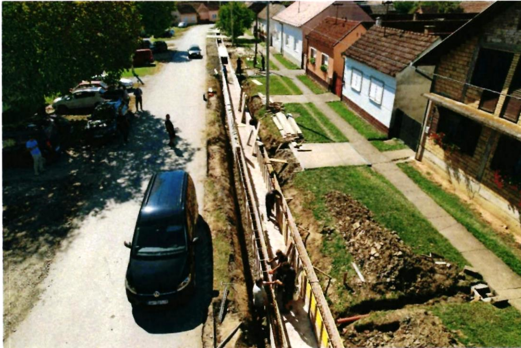
Slika 9. Uređenje kanala Korita, naselje Tomica
