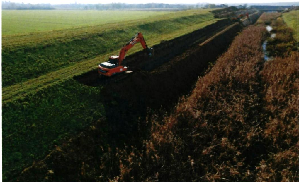
Slika 5. Iskop bermi uz ZLK Biđ polja, općina Garčin
