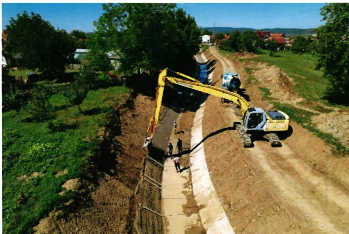
Slika 7. Uređenje korita v. Brezna, naselje Trnjani – tijekom izvođenja radova
