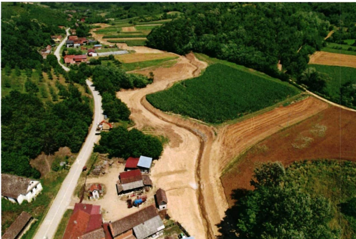
Slika 11. Uređenje vodotoka Gnojnica, naselje Brčino - Ravan
