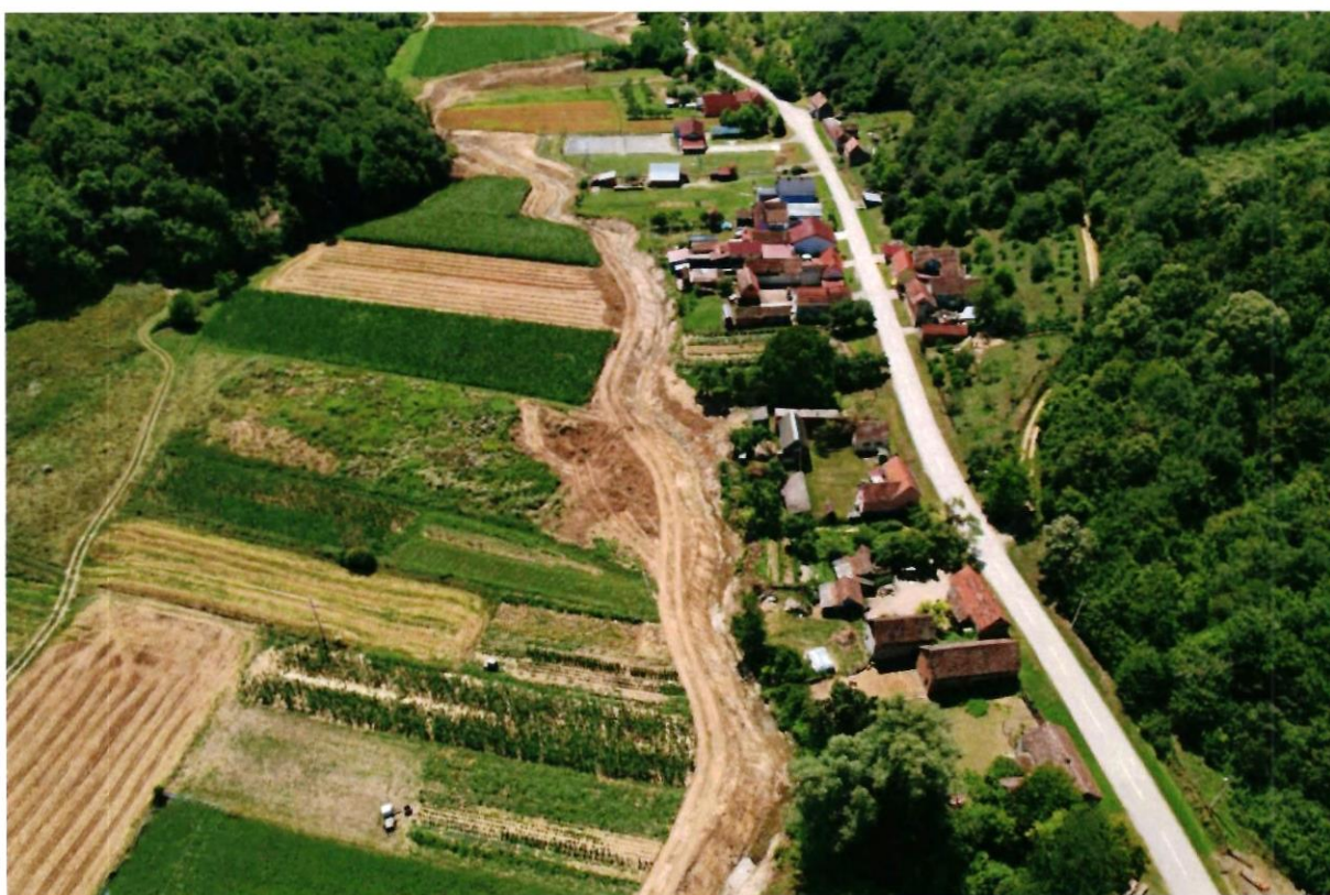
Slika 12. Uređenje vodotoka Gnojnica, naselje Brčino - Ravan
