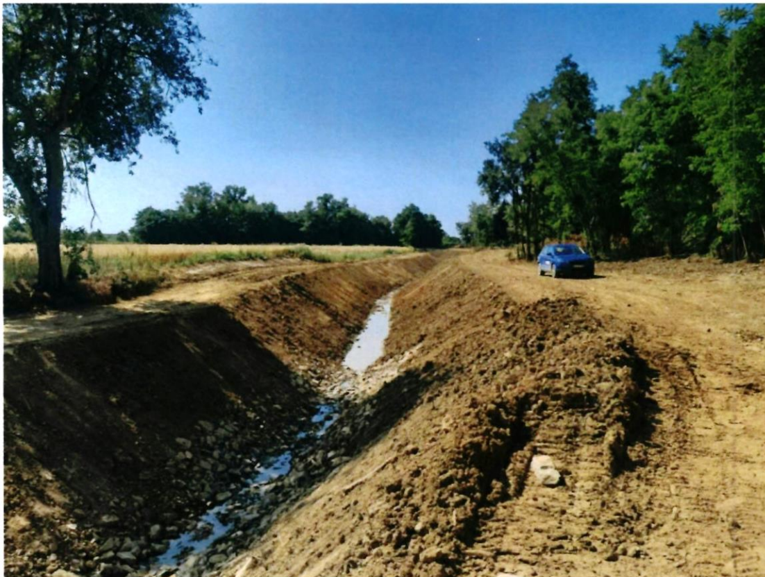
Slika 13. Uređenje vodotoka Berevac, naselje Novo Topolje
