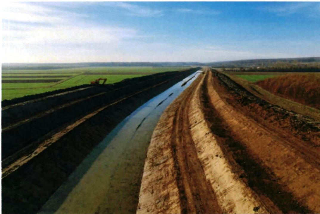
Slika 4. Uklanjanje nanosa iz korita ZLK Biđ polja, općina Garčin – stanje nakon izvršenih radova
