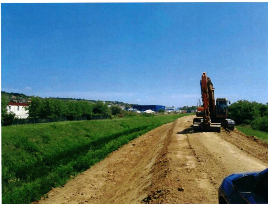
Slika 6. Iskop bermi uz ILK Jelas polja, grad Slavonski Brod
