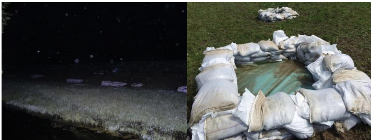
Slika 1.6: Preventivna obrana na mjestima podvira za vrijeme trajanja velikih voda 2014. god
