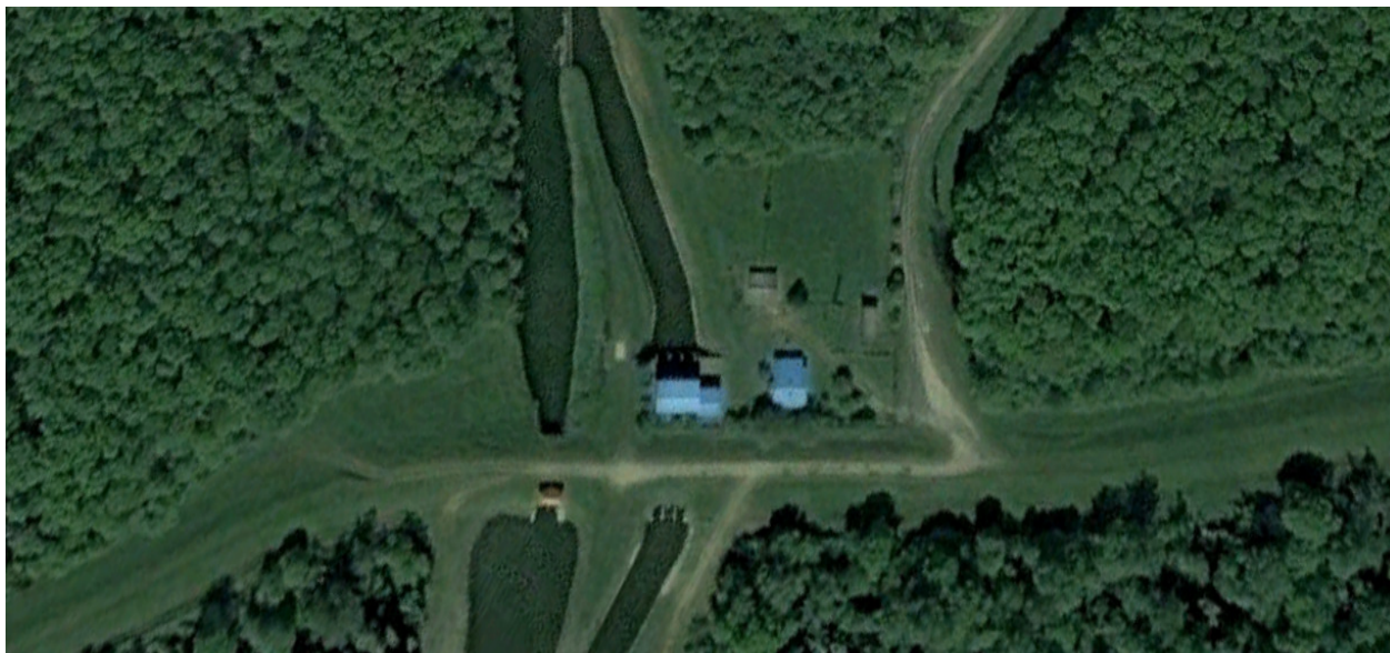
Slika 1.8: Crpna stanica Crnac
