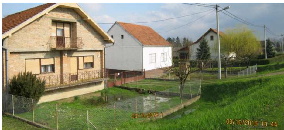
Slika 1.1-8. Procjedne vode u dvorištima i okućnicama obiteljskih kuća za vrijeme povodnja
