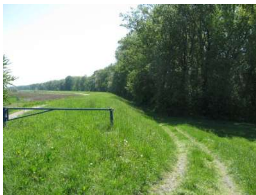
Slika 1.1.1-7. i 1.1.1-8. Tipske željezne brklje na početku i kraju nasipa između Mačkovca i Doline
