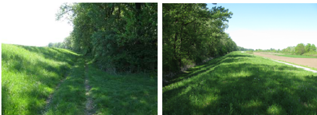
Slika 1.1-9. i 1.1-10. Postojeći nasip
