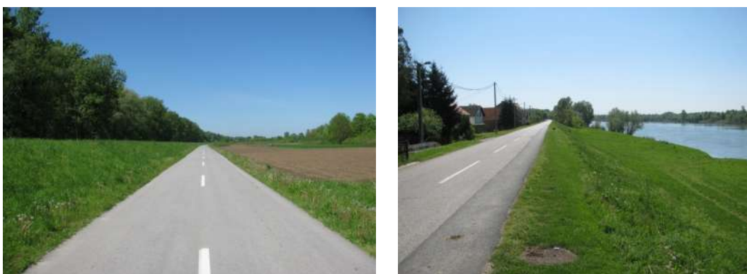
Slika 1.1.1-11. i 1.2.1-12. LC 42019 pokraj nasipa i ŽC 4156 po kruni nasipa
