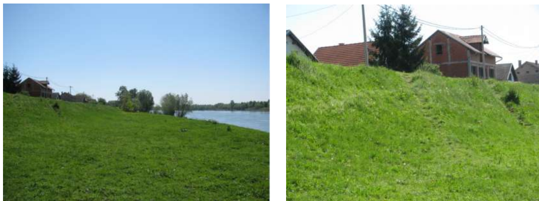
Slika 1.1-5. i 1.1-6. Kolotrazi po pokosu nasipa
