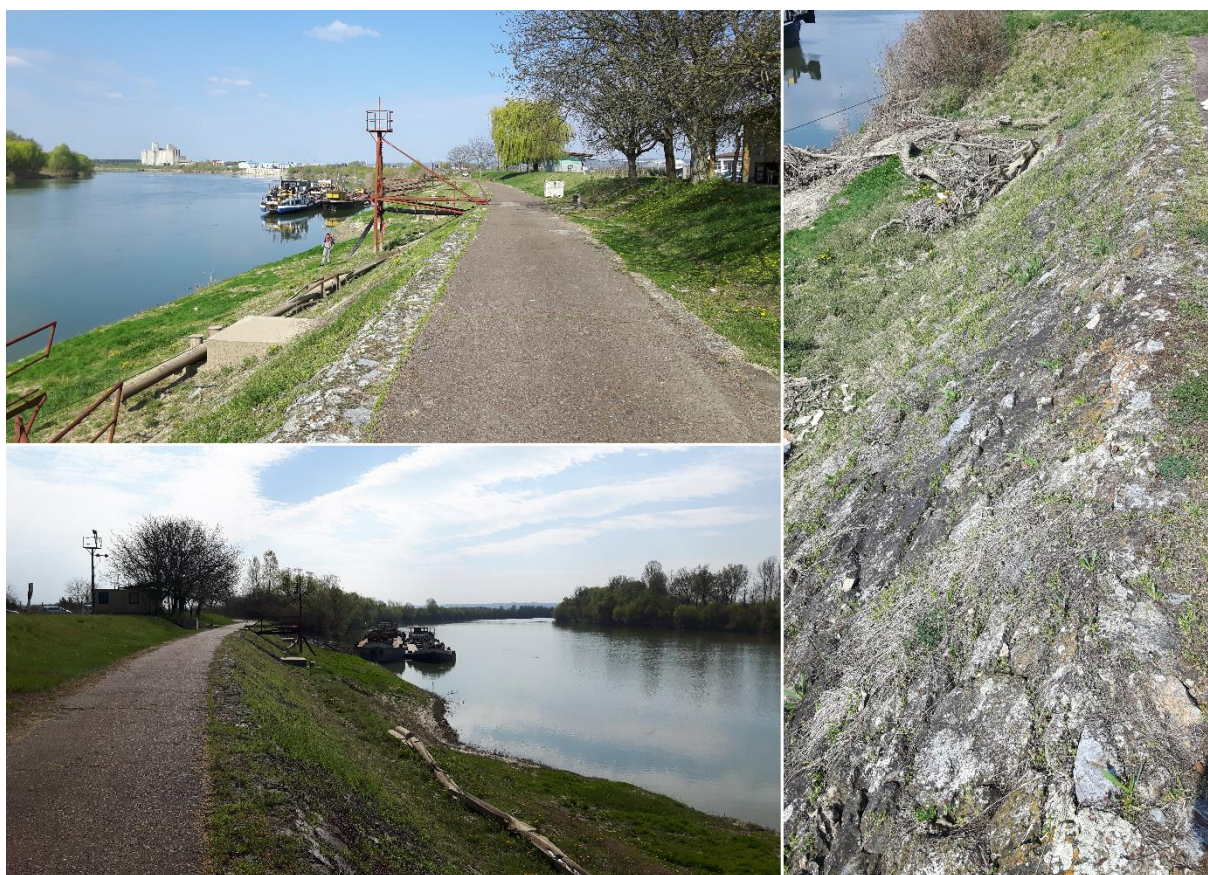
Slika 2.2.1.-1. Postojeće stanje lijevoobalnog nasipa rijeke Save u Rušćici i dijela obaloutvrde koja nije predmet ovog zahvata
