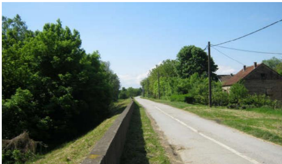
Slika 2.1.-1. Lokacija početka trase planiranog zahvata rekonstrukcije nasipa u naselju Donji Varoš
