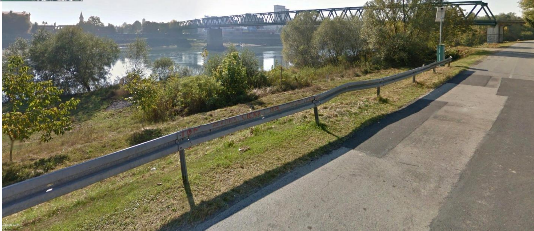
Sl. 3.11-5: Točka 3: Pogled na most Gradiška
