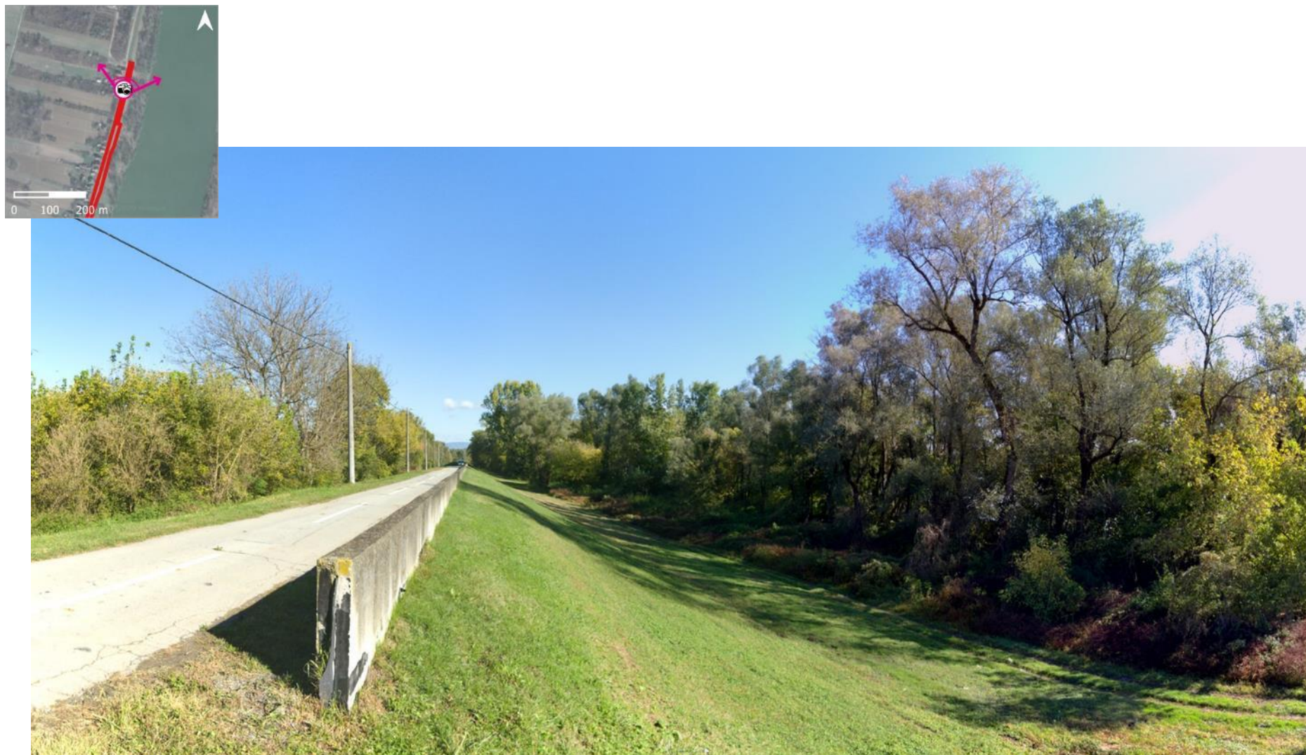
Sl. 3.11-3: Točka 1: Pogled na početnu točku planiranog zahvata i segment postojećeg nasipa gdje je već izgrađen armirano-betonski zid (km 0+000 do km 0+174) u naselju Donji Varoš
