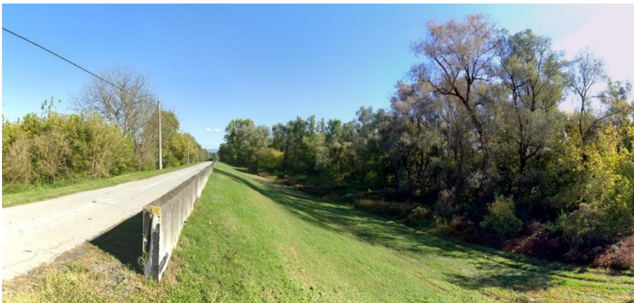
Sl. 3.8-2: Pogled na početnu točku planiranog zahvata i segment postojećeg nasipa gdje je već izgrađen armirano-betonski zid (km 0+000 do km 0+174) u naselju Donji Varoš
