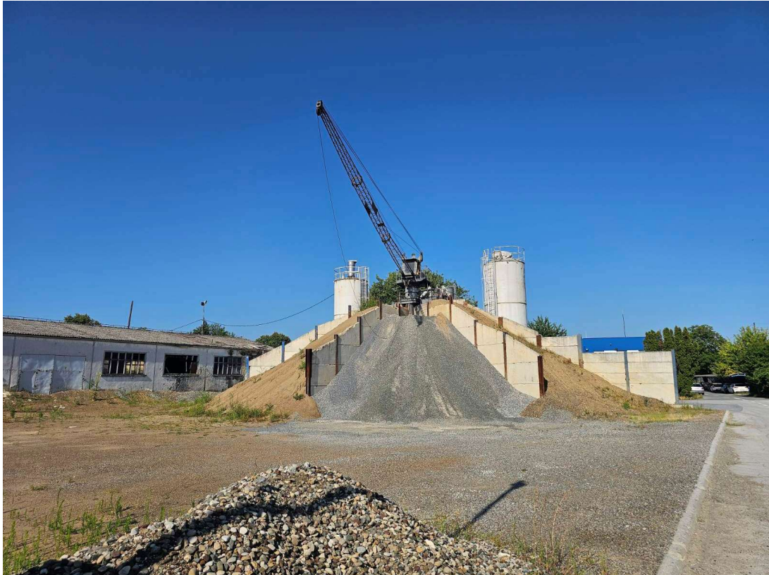
Slika 23. Betonara– zvjezdasto skladište kamenih agregata i toranj s korpom za doziranje kamenih agregata (Izvor: PZC BROD d.o.o., kolovoz 2025.)
