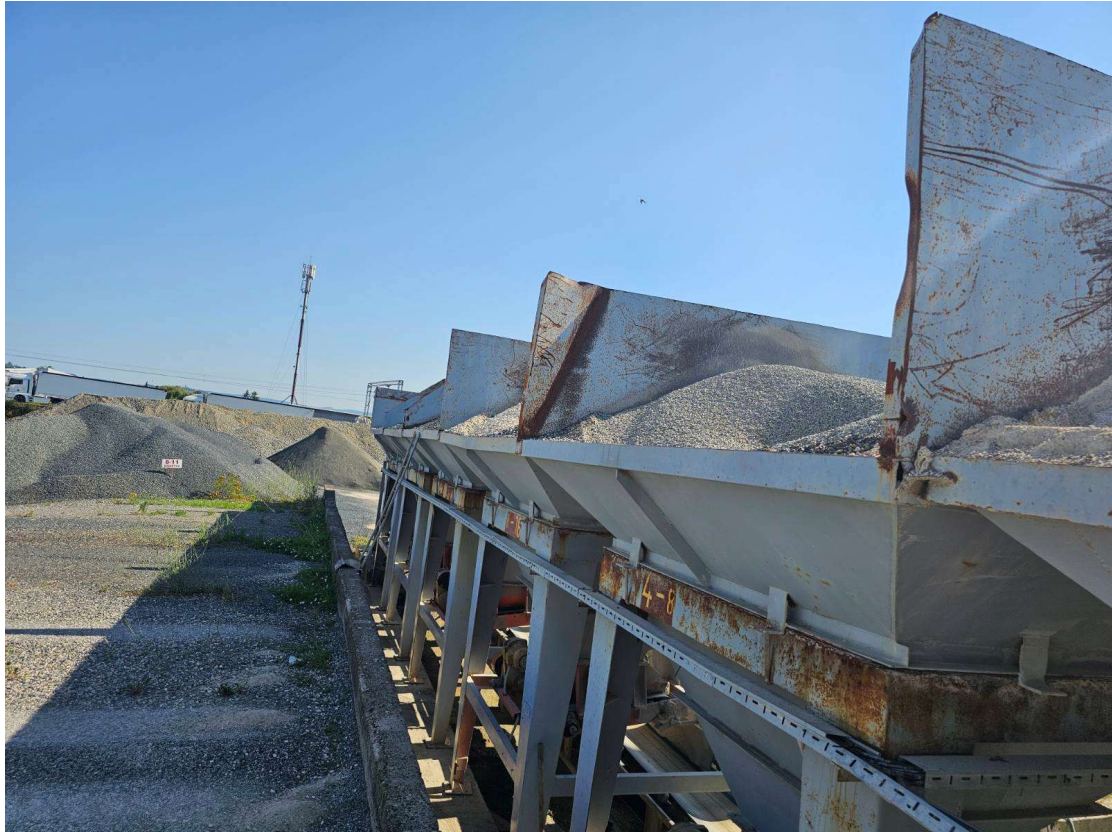
Slika 19. Asfaltna baza – uspini koševi (Izvor: PZC BROD d.o.o., kolovoz 2025.)
