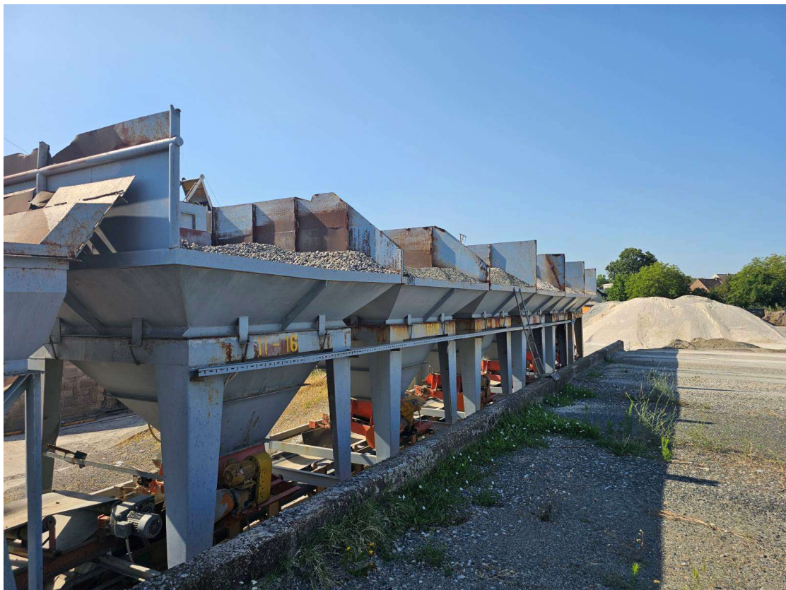
Slika 20. Asfaltna baza– uspini koševi (Izvor: PZC BROD d.o.o., kolovoz 2025.)
