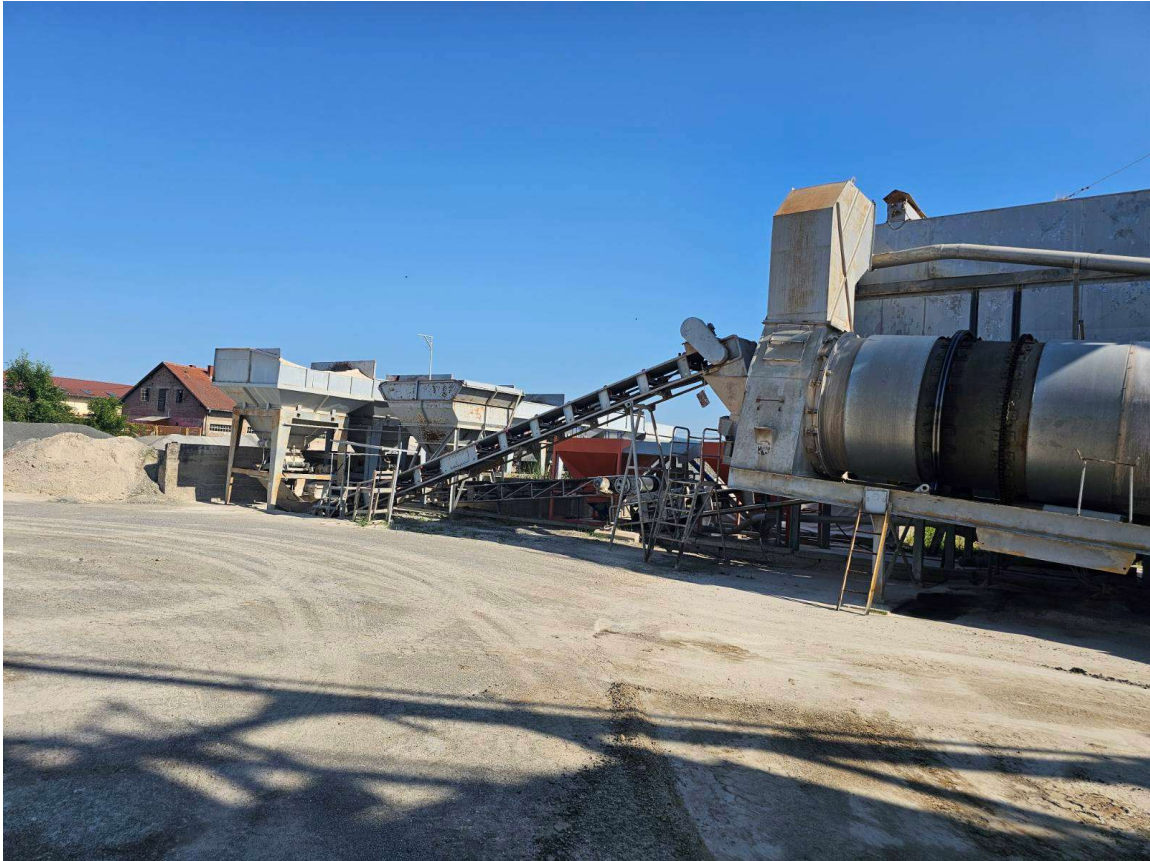
Slika 15. Asfaltna baza – trakasti transporter kamenih agregata (Izvor: PZC BROD d.o.o., kolovoz 2025.)
