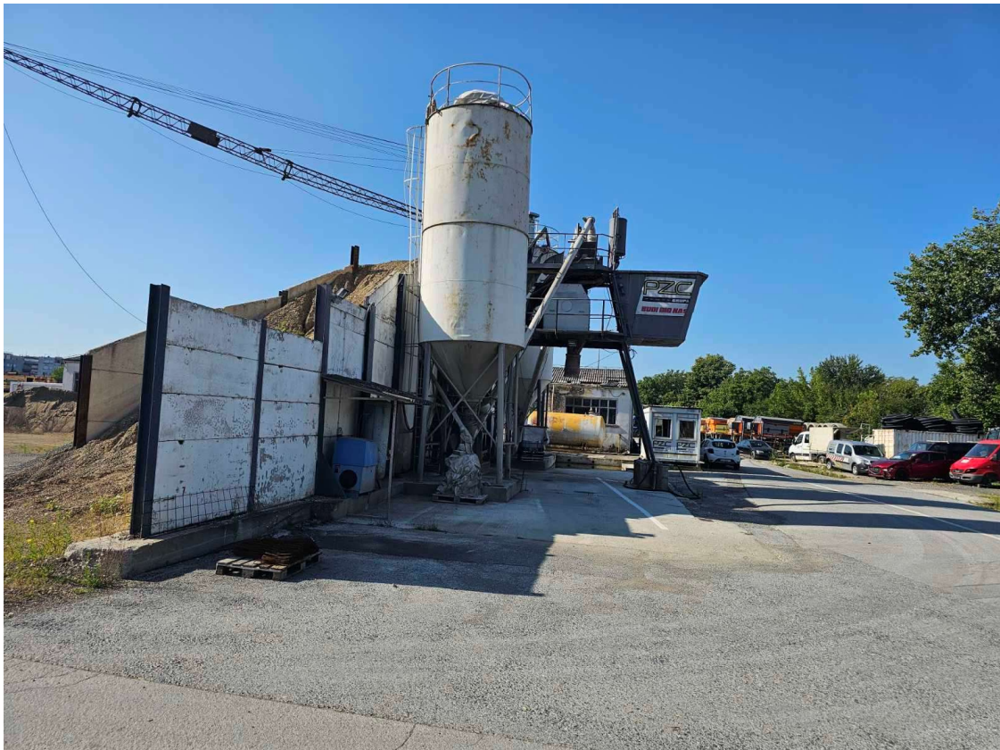
Slika 25. Betonara – silos cementa (Izvor: PZC BROD d.o.o., kolovoz 2025.)
