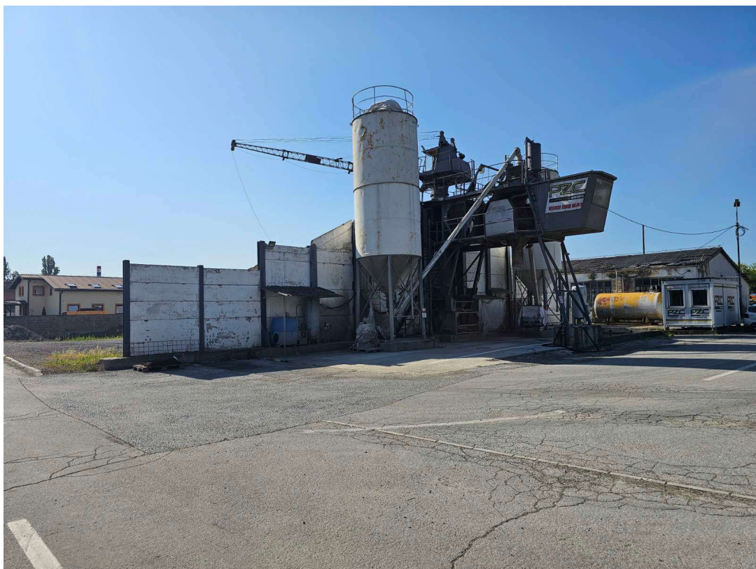
Slika 26. Betonara – silos cementa (Izvor: PZC BROD d.o.o., kolovoz 2025.)
