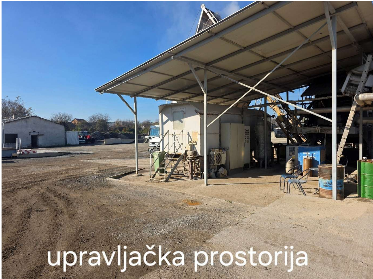
Slika 12. Asfaltna baza – upravljачka prostorija (Izvor: PZC BROD d.o.o., kolovoz 2025.)
