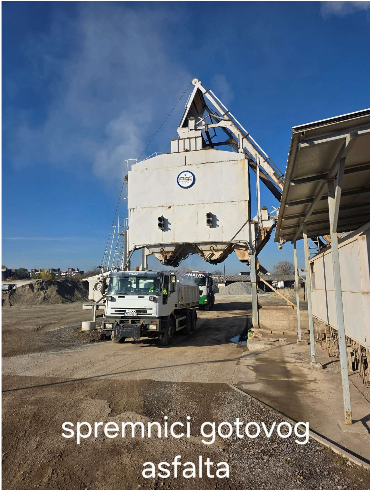
Slika 13. Asfaltna baza – spremnici gotovog asfalta (Izvor: PZC BROD d.o.o., kolovoz 2025.)
