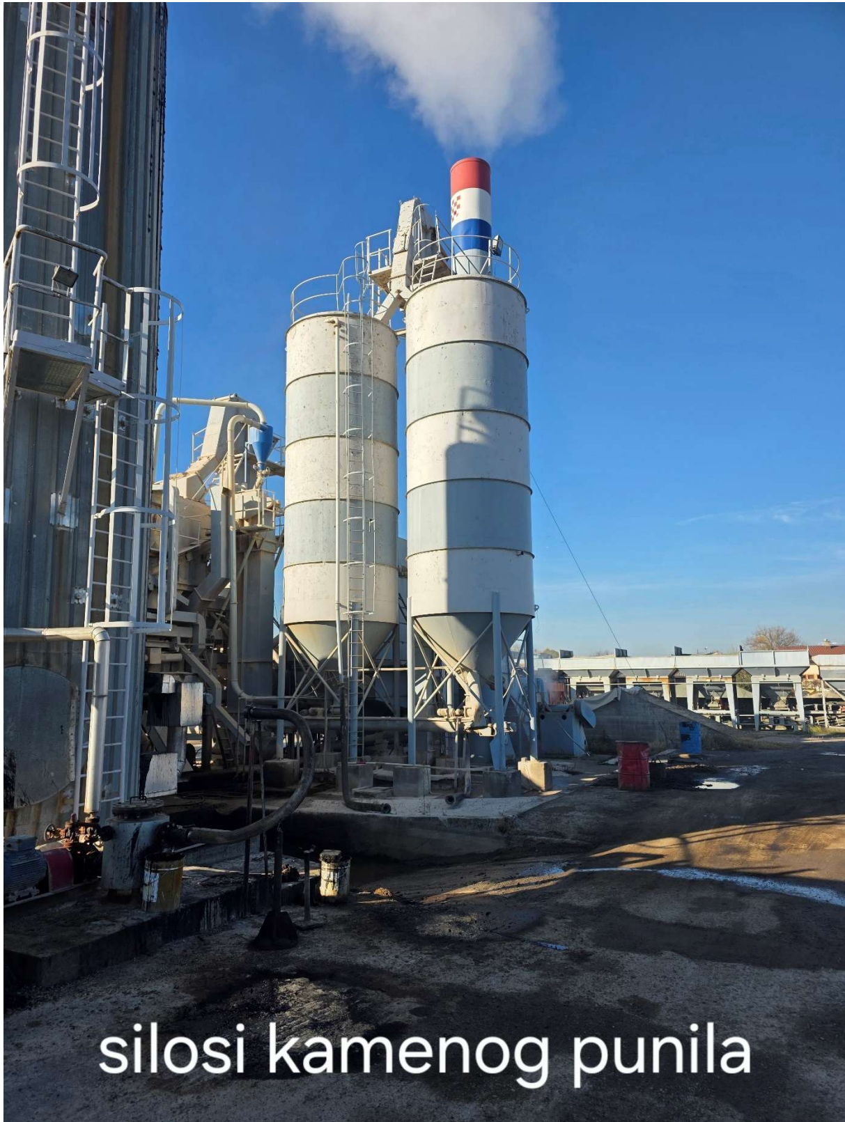
Slika 10. Asfaltna baza – silosi kamenog punila (Izvor: PZC BROD d.o.o., kolovoz 2025.)
